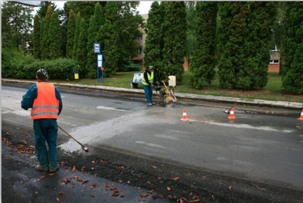
1 Řezání na zastávce u zámku
