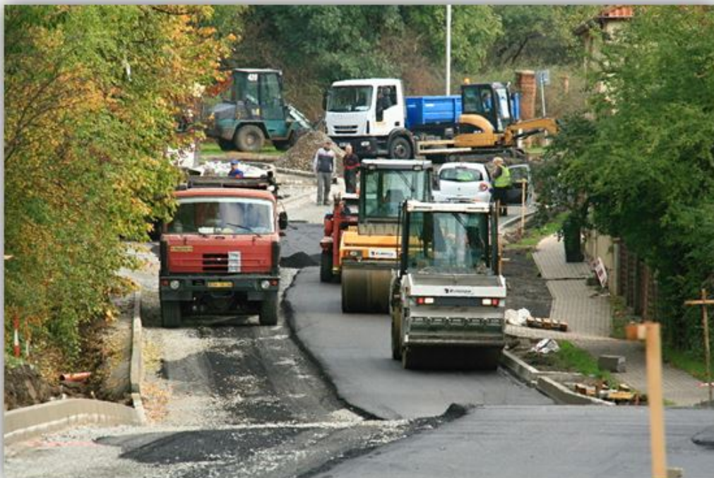
11 POKLÁDKA ASFALTOVÉ VRSTVY
