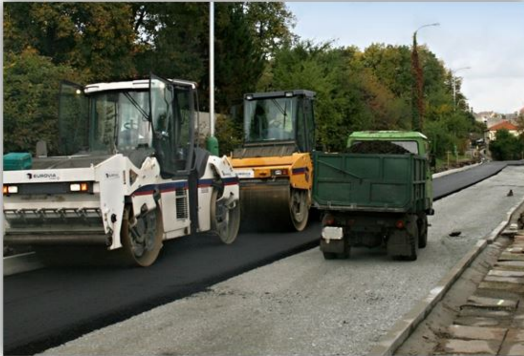
13 ROVNOU S UHLÍM DO ASFALTU
