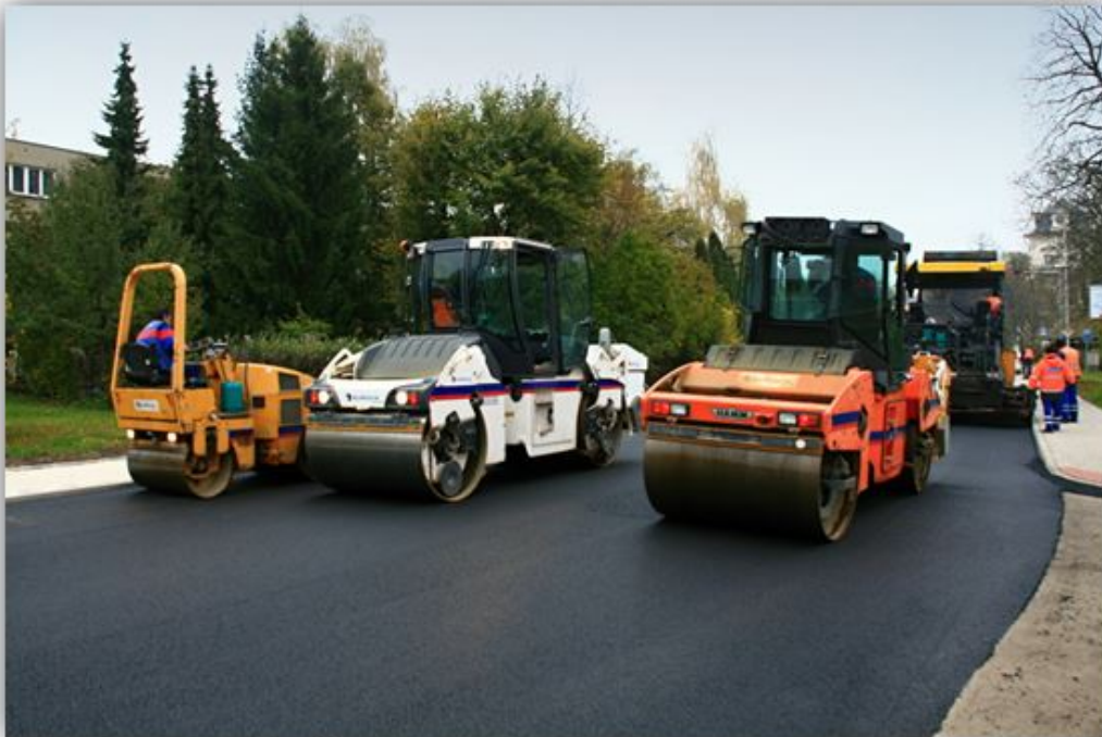
13 KONEČNÁ ÚPRAVA VOZOVKY
