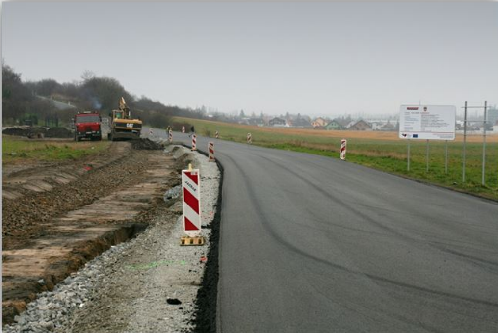
5 ZDE JEŠTĚ BUDE DOST PRÁCE
