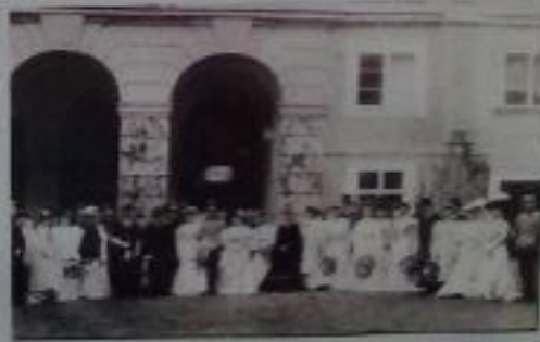
Svatba Hlady Klugrovové v roce 1940, v pozadí je vidět detail východního křídla.
