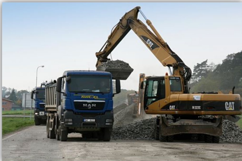
5 DEPO NAKLÁDKY POD BORKEM
