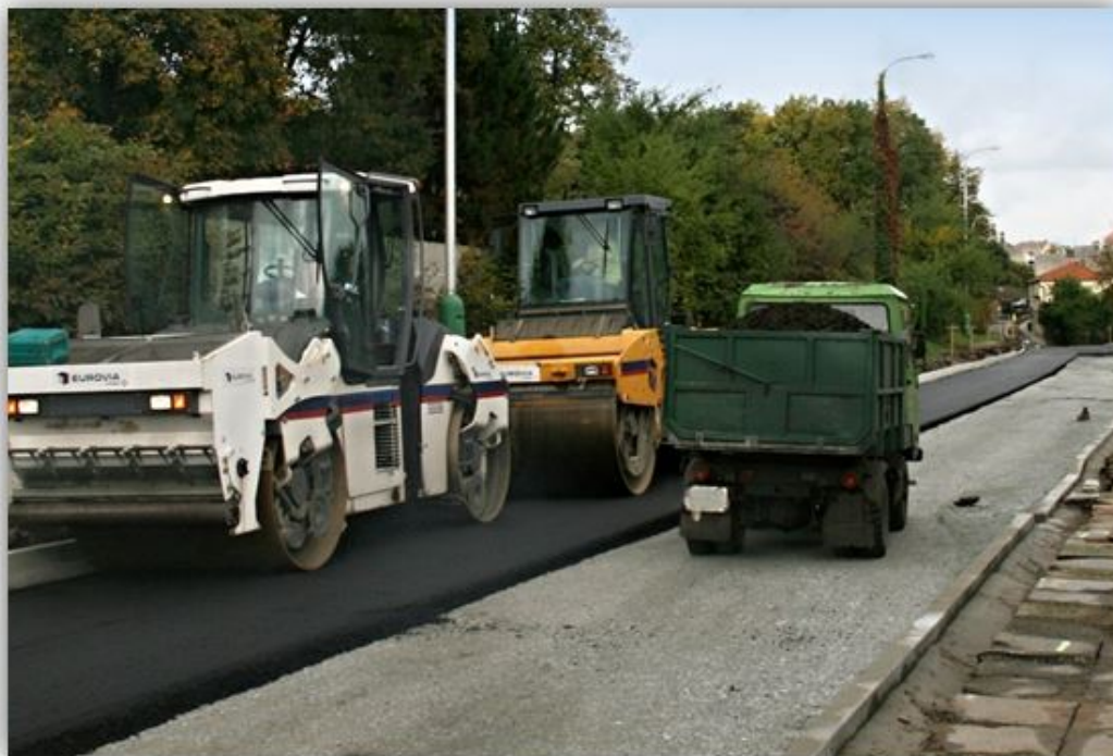
13 ROVNOU S UHLÍM DO ASFALTU
