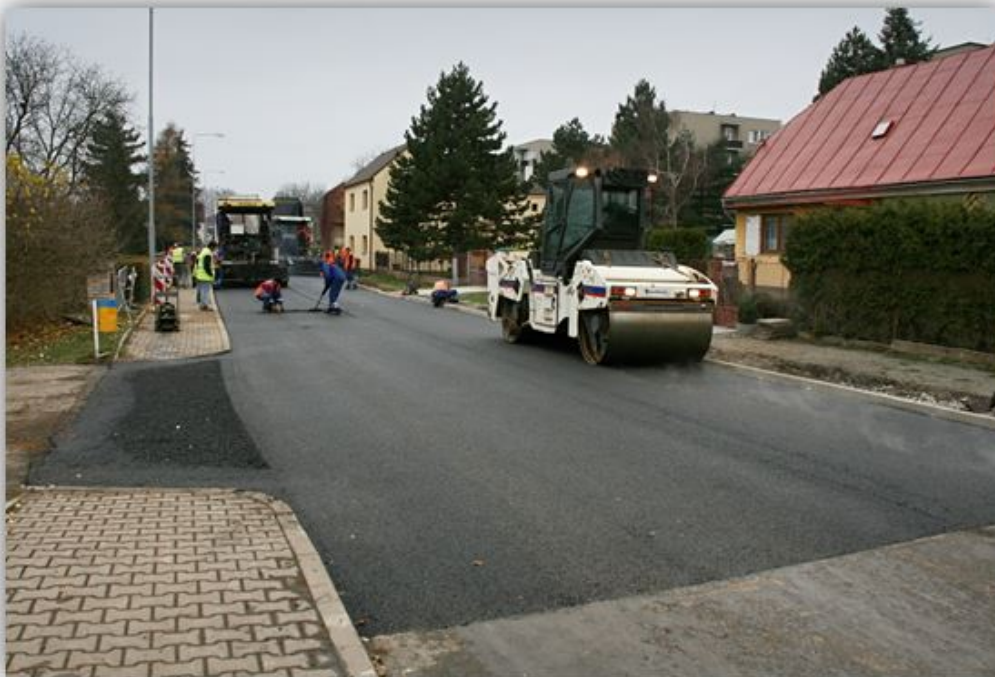
7 VÁLCE DOKONČUJÍ POVRCH
