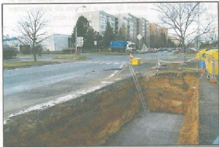
Takto vypadala hluboká jáma na ulici J. Palacha u křižovatky s třídou V. Klementa začátkem prosince, než do ní byly instalovány pomocí autojeřábu čtyři podzemní kontejnery na odpad.
