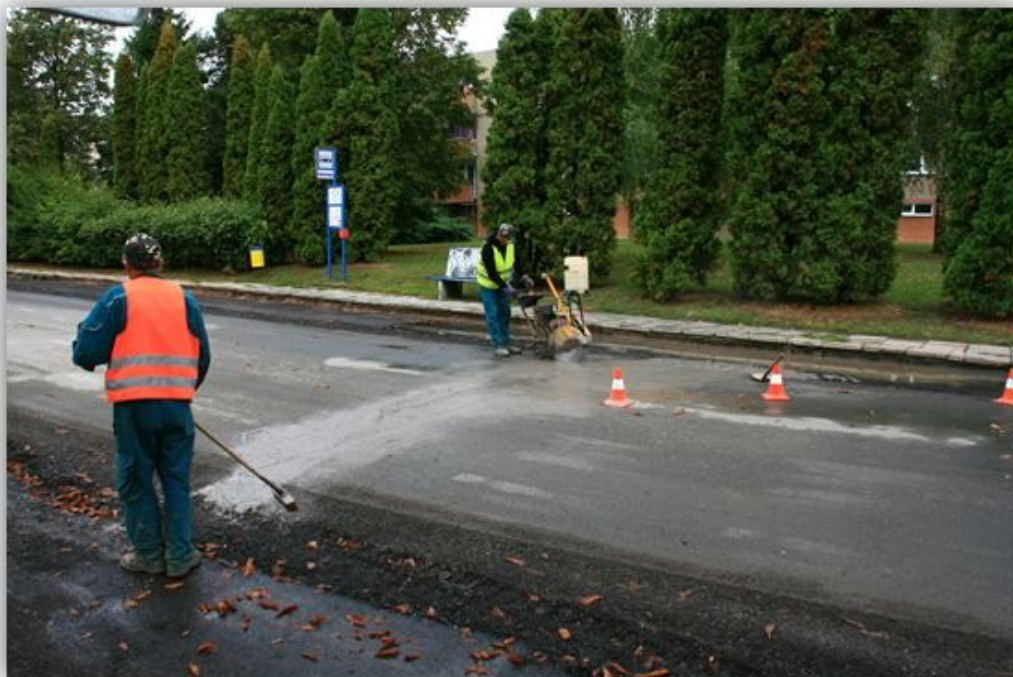
1 Řezání na zastávce u zámku
