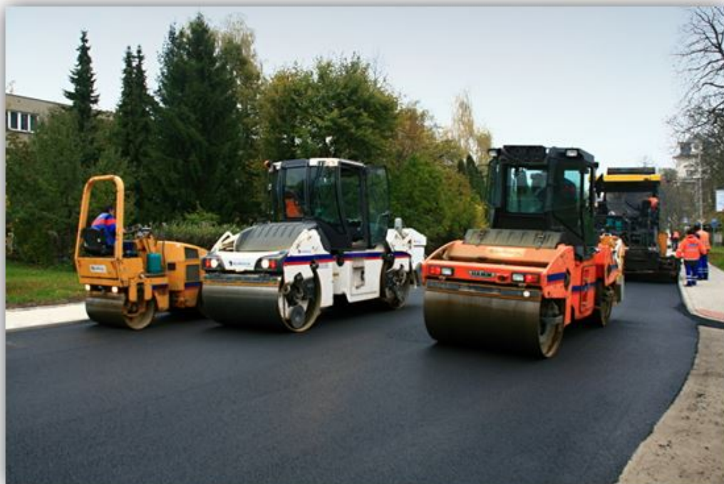
13 KONEČNÁ ÚPRAVA VOZOVKY
