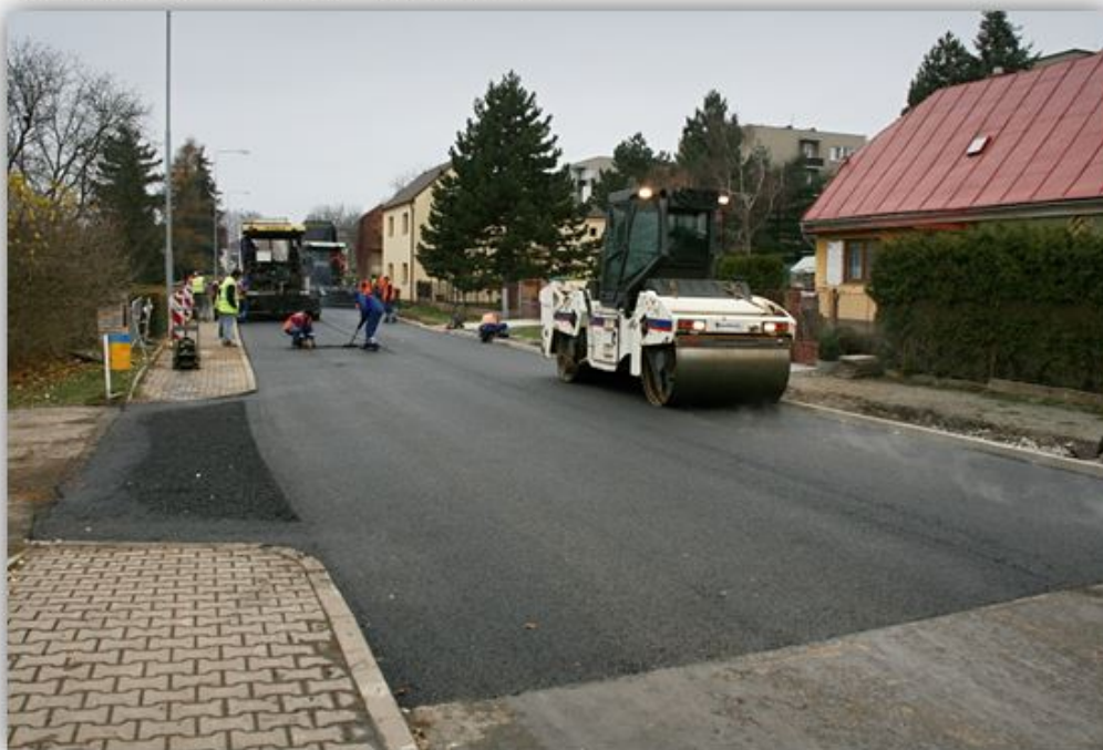
7 VÁLCE DOKONČUJÍ POVRCH
